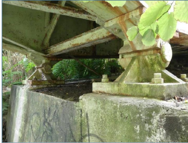
Figure 15 - Vue sur appareil d'appuis sur pile - IDP 2019 (réf. [1])
