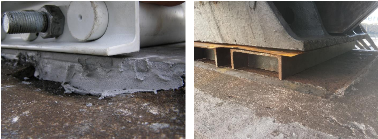
Figure 14 - Vue sur exemple de traitement d'une platine de roulement : décapage de la calamine sur tôle d'origine et collage d'une nouvelle platine de roulement
