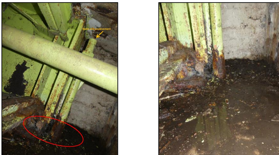
Figure 13 - Vue sur barre anti-soulèvement sur culée - IDP 2019 (réf. [1])
