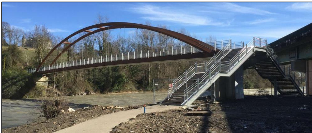
Figure 18 - Exemple passerelle Bow-string à Pau - portée 70m
