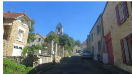
Lainville-en-Vexin, architectures en pierre calcaire locale
