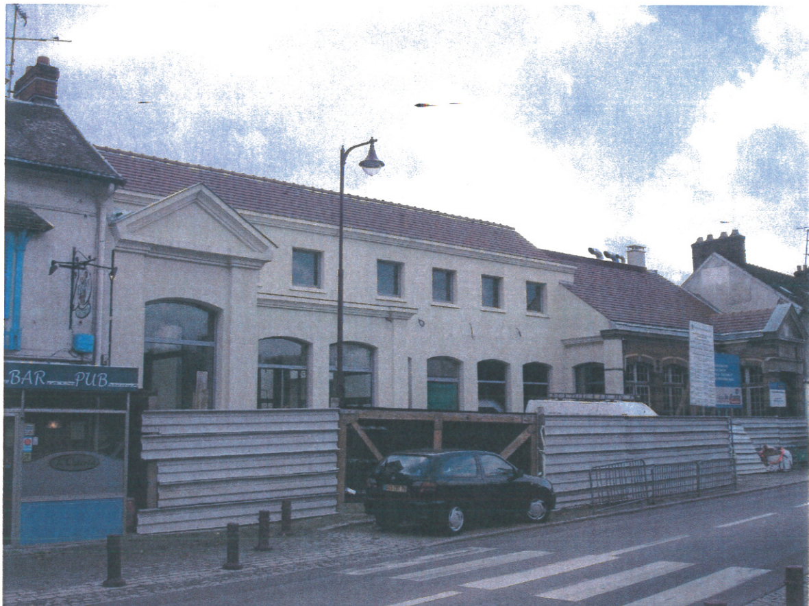
Vue n° 6 – La nouvelle médiathèque rue Nationale en face de l'hospice
