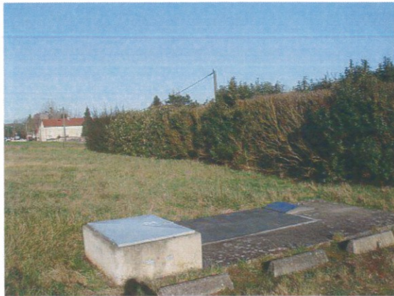
Piezomètre (désigné par C) dans le PPI du captage F2
