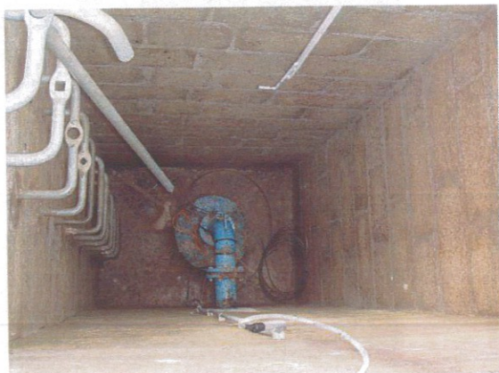
Intérieur du captage F3
