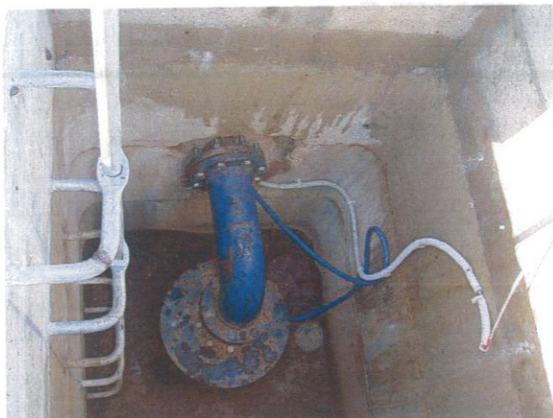
Intérieur du captage F1
