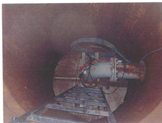
Intérieur du captage F7
