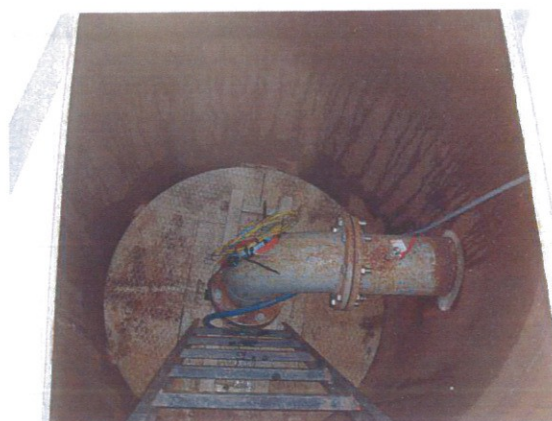
Intérieur du captage F8
