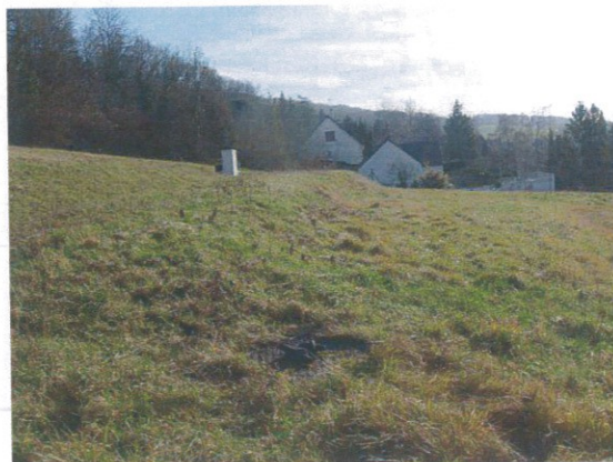
Le piézomètre (désigné par D) dans le PPI des captages F3 et F6
