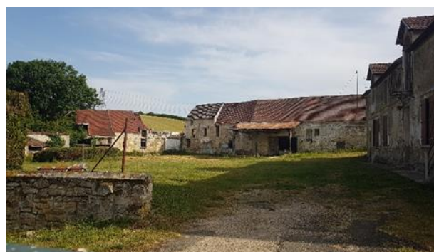
Vue de la Ferme Drocourt que les propriétaires souhaiteraient transformer en habitations
