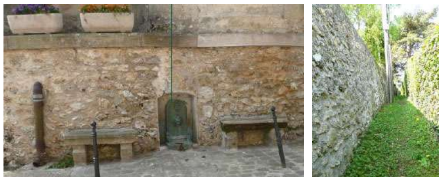
Borne-fontaine devant l'église d'Evécquemont et mur en meulières (source : charte paysagère d'Evécquemont)
