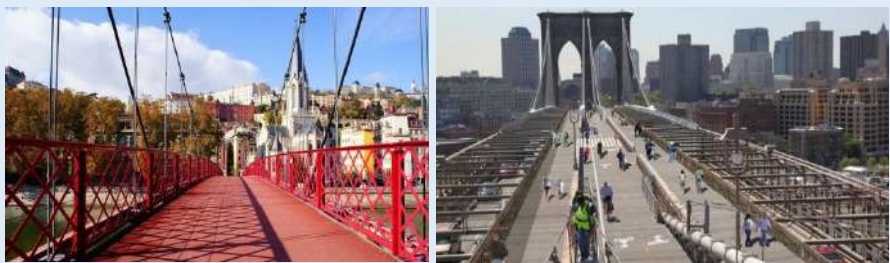
Passerelle sur la Saône à Lyon et Brooklyn bridge à New York City, un pont pour tous les modes de transport : piétons, cycles, voitures et voies ferrées
