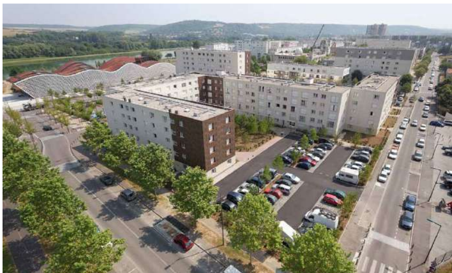
Projet de rénovation urbaine du mantois (quartier des peintres et des médecins), venant améliorer les paysages et le cadre de vie (source : EPAMSA)
