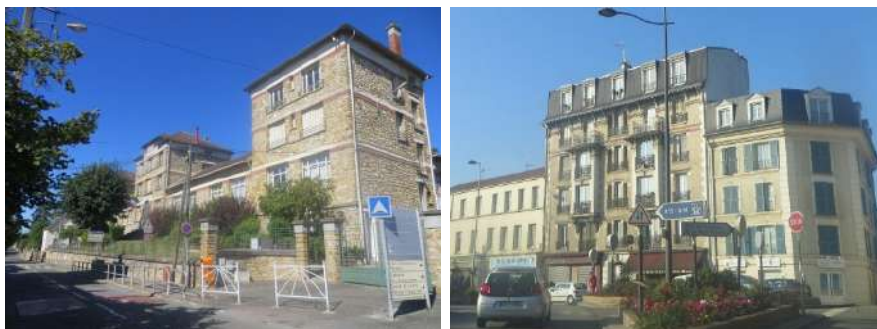
Immeuble collectif en meulière, Meulan-en-Yvelines (à gauche) et immeuble de rapport (à droite) (source : Even conseil)
