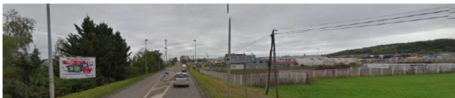
Une entrée sur une séquence à requalifier dans une zone commerciale et artisanale
