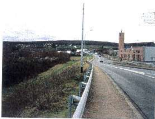
1. Depuis le carrefour au-dessus de l'A14 et la friche sur la gauche.
