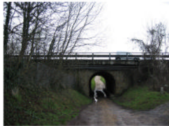
Passage sous l'A13, chemin des Glaises
