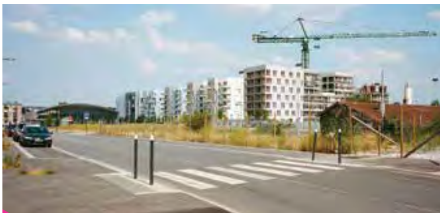
Le rythme de construction a été particulièrement soutenu en 2018, avec 2 900 nouveaux logements contre 2 300 en moyenne ces dernières années
