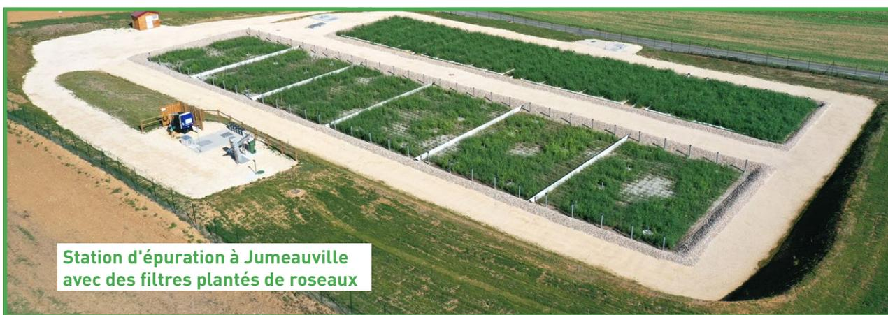
Station d'épuration à Jumeauville avec des filtres plantés de roseaux
