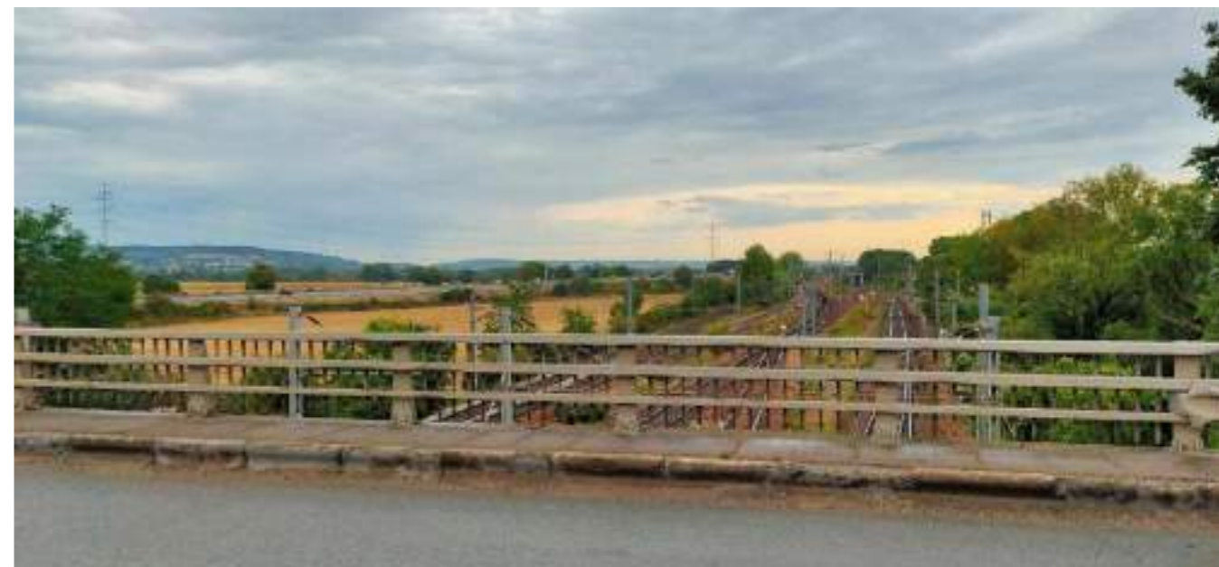
Talus de franchissement de la voie ferrée par la RD130, une rupture physique majeure en bordure est du site - Source : Even Conseil
