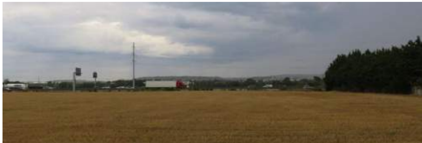
L'Autoroute A13, un axe viaire majeur omniprésent dans les paysages d'Epone et de Mézières-sur-Seine - Source : Even Conseil
