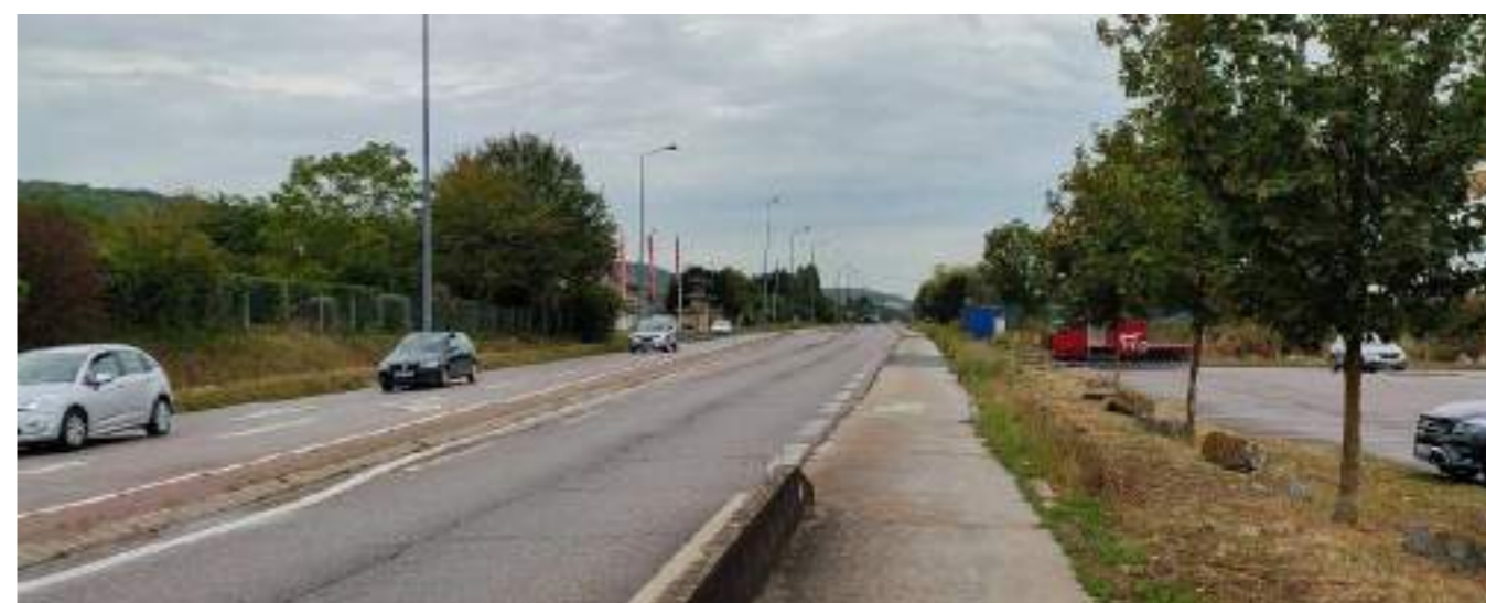
La piste cyclable de la RD113, d'épaisseur confortable pour les modes doux mais peu sécurisée car au contact direct de la route - Source : Even Conseil
