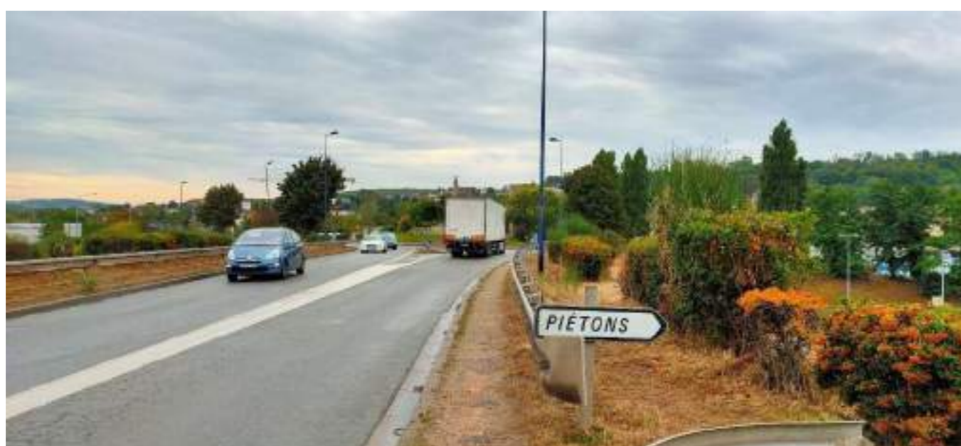
La RD130, un axe majeur non aménagé pour les déplacements piétons, et pourtant seul axe franchissant la voie ferrée, l'autoroute et la Seine vers le nord : trottoir délaissé, cheminement peu confortable pour les piétons et signalétique peu claire - Source : Even conseil
