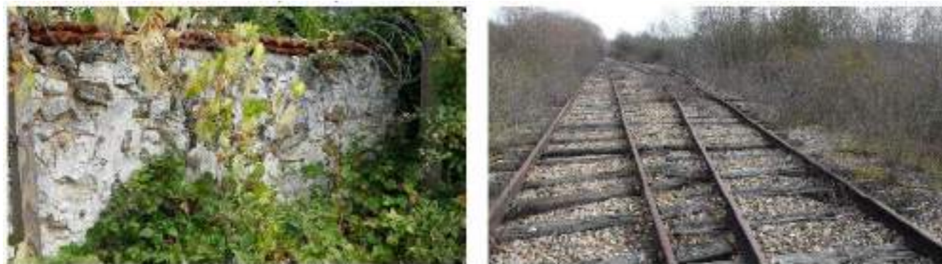
Mur en pierre (à gauche) et voie ferrée désaffectée (à droite) favorables à la thermorégulation de l'espèce
