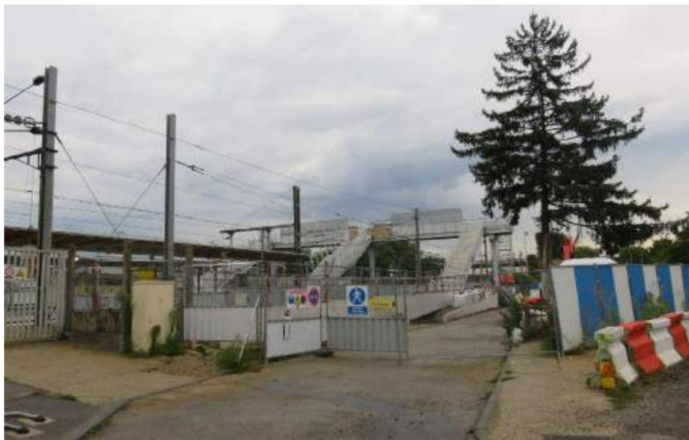
Une passerelle piétonne permettant d'accéder aux quais et de franchir la voie ferrée, ainsi qu'une nouvelle passerelle en construction, en faveur des personnes à mobilité réduite - Source : Even Conseil
