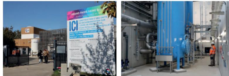
Une nouvelle unité de décarbonatation a été mise en service sur la commune de Vernouillet en 2022. Elle permet l'alimentation en eau adoucie de 27 000 habitants situés dans les communes de Chapet, Verneuil-sur-Seine et Vernouillet. Capacité de production : 400 m<sup>3</sup> / heure. Avec cette nouvelle installation, 271 000 habitants bénéficient de ce service dans 45 communes du territoire. Montant du projet : 4 956 398 €.
