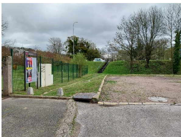
Chemin piéton et escalier accès depuis RD
