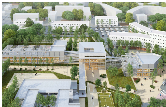
Cité éducative Simone Veil-Architectes : Badia Berger Architectes
