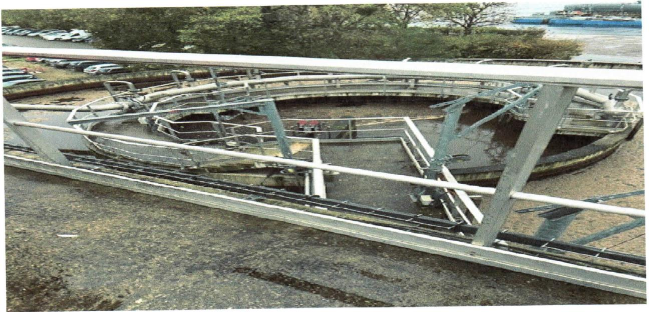
Photo : Vue d'une partie du bassin de traitement biologique et aération des eaux usées avant leur rejet dans la Seine
