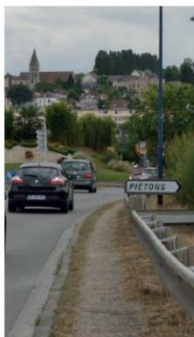
Rive de la RD130 Réhabiliter les trottoirs
