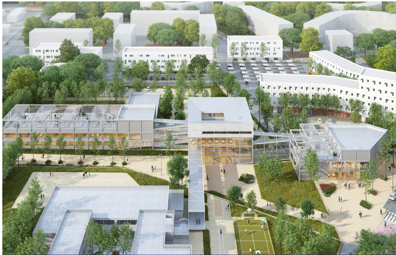
Cité éducative Simone Veil-Architectes : Badia Berger Architectes
